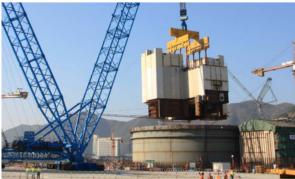
CA01模块吊装 (三门2号机组)
