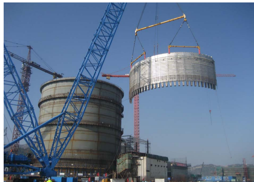
CA03模块吊装 (三门1号机组)
